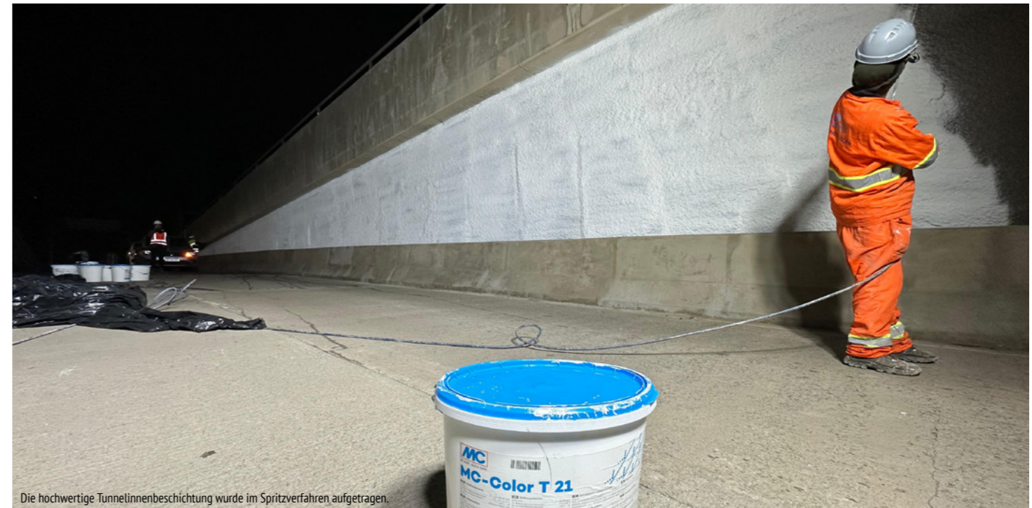
Die hochwertige Tunnelinnenbeschichtung wurde im Spritzverfahren aufgetragen.
