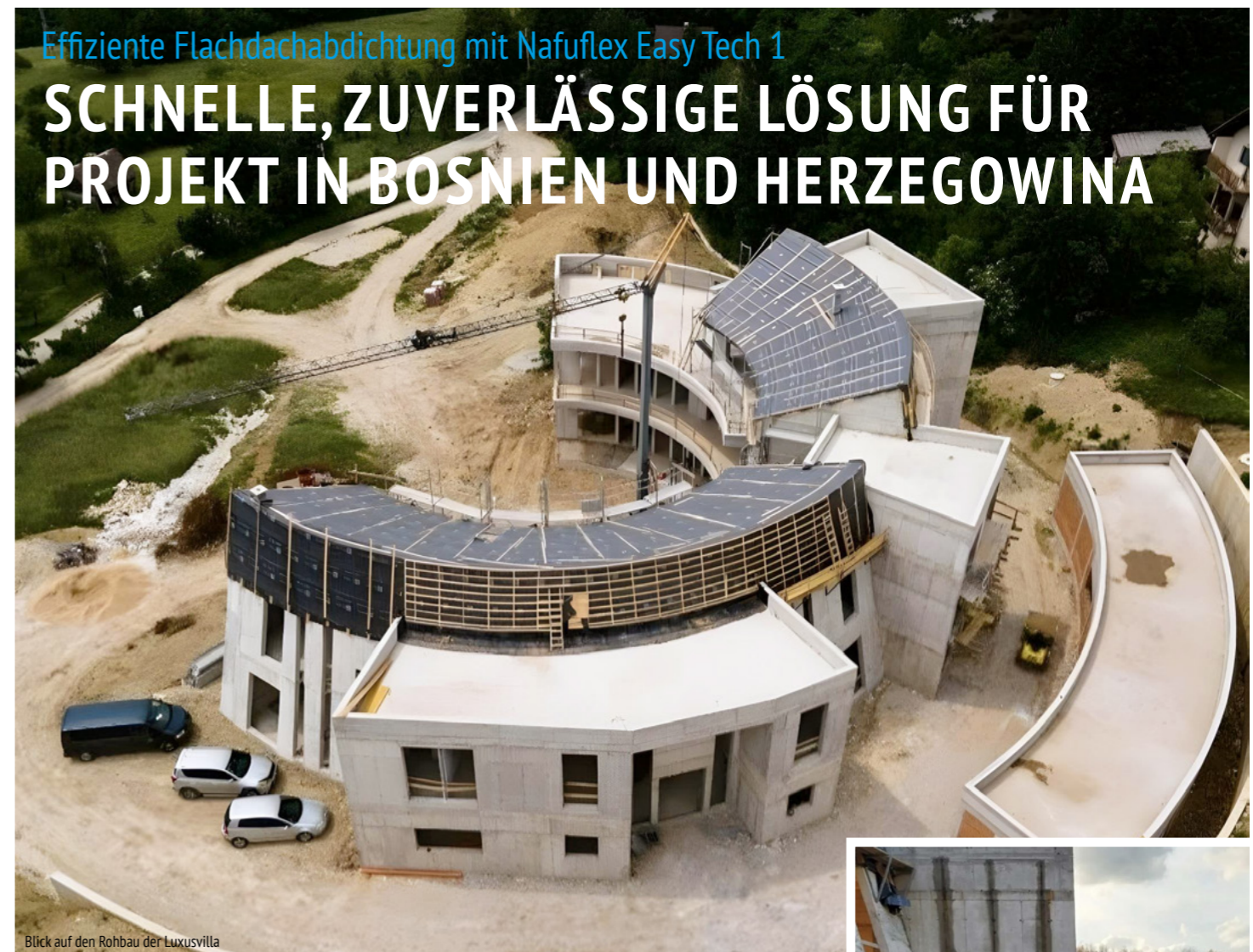
Blick auf den Rohbau der Luxusvilla
