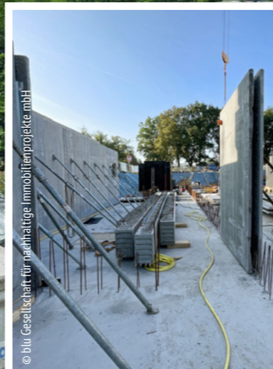
Die „Musterbude“ der OTTO WULFF Bauunternehmung in Hamburg besteht aus R-Beton, der z. T. 100 % rezyklierte Gesteinskörnung enthält und erstmalig beim Bau einer Hamburger Schule eingesetzt wurde.
