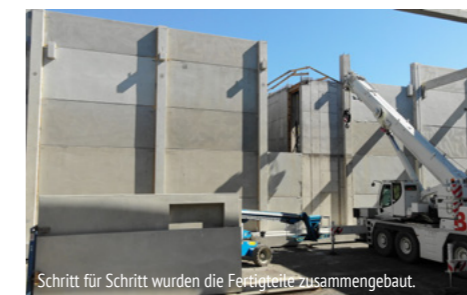
Schritt für Schritt wurden die Fertigteile zusammengebaut.
