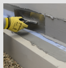
MC-FastTape einbetten und letzte Abdichtungslage aufbringen.
