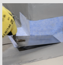
MC-FastTape AE (Außenecke) oder MC-FastTape IE (Innenecke) in die frische erste Lage einbetten.
