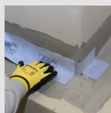
MC-FastTape ca. 10 cm überlappend mit Abdichtungsmaterial an die Innen- oder Außenecke anschließen.
